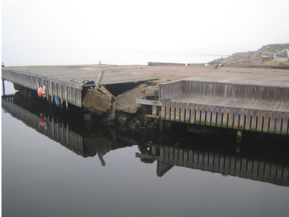
Bild 11. Ras i utkanten av fyllningen intill Tubberöd 1:252. Vy åt nordväst.
