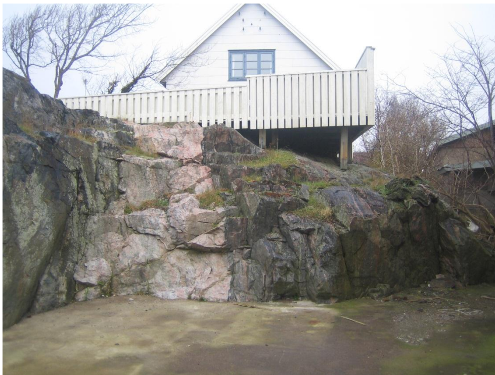
Bild 6. Fastighet Tubberöd 1:248 är grundlagd på berg. Vy åt nordost.
