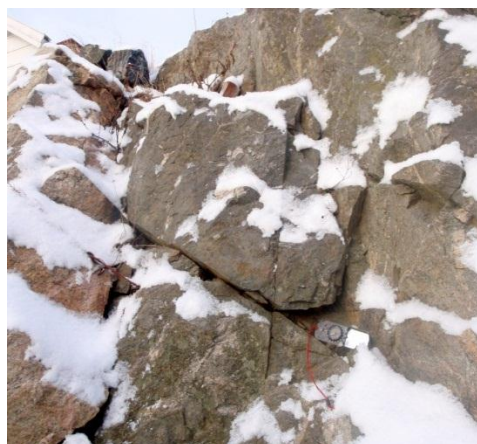
Bild 15. Block 1, vy mot norr
