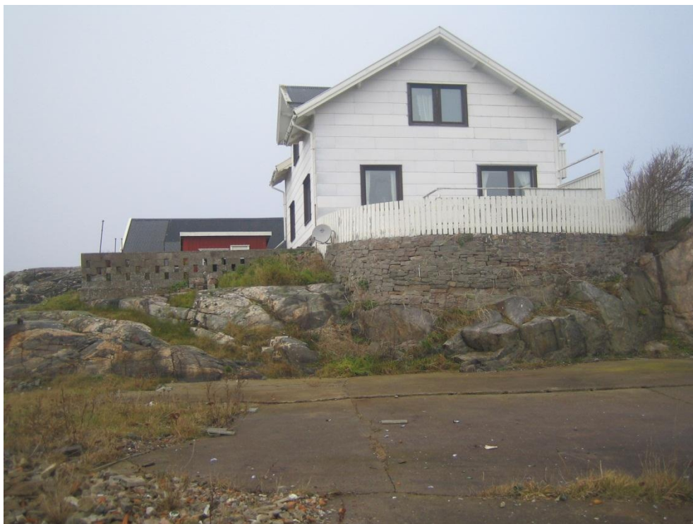
Bild 3. Fastigheten Tubberöd 1:256 är grundlagda på berg. Vy åt norr
